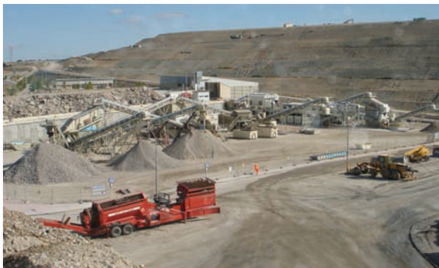
Figura 8. Planta de tratamiento de RCD heterogéneos.
