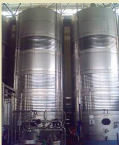
Figura 17. Verticalidad de los silos después de la inyección.
