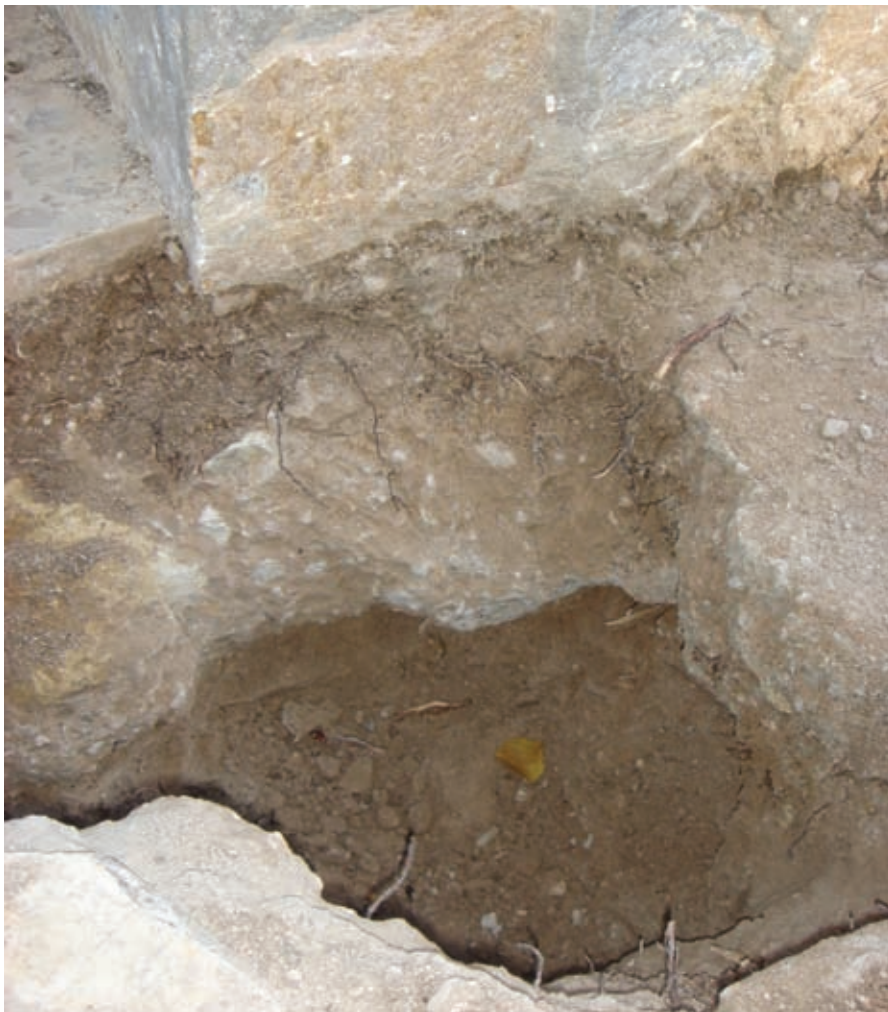
Figura 5. Detalle de cata de cimentación.
