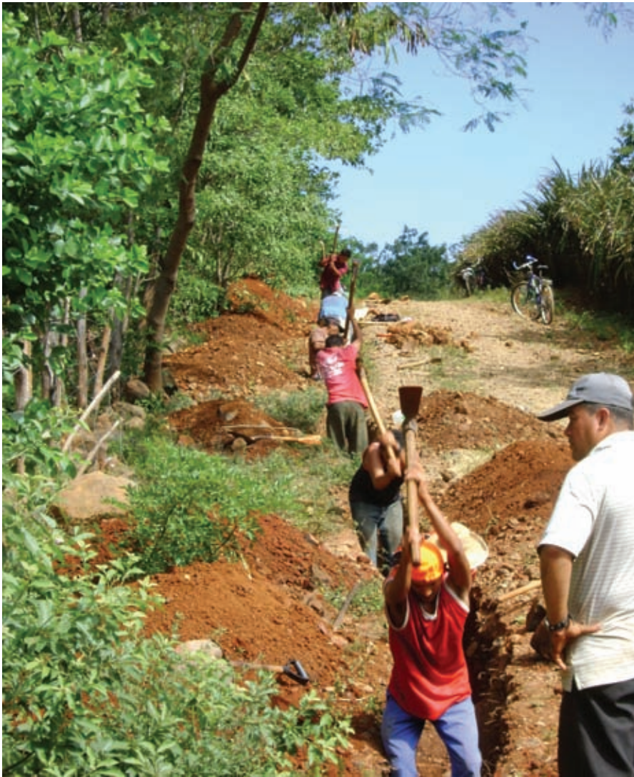
Figura 2. Aperturas de zanjas.
