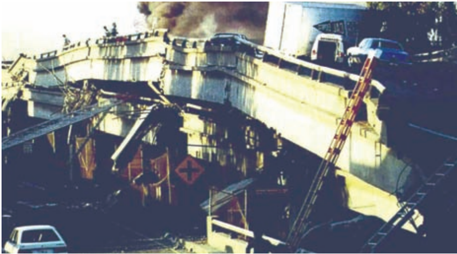
Figura 9. Efecto del terremoto de Loma Prieta (1989) sobre una autopista en San Francisco. (Dangerous Earth, 1997)
